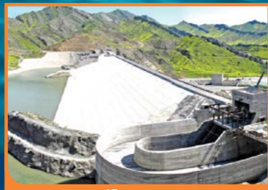
سد مخزنی خداآفرین خداآفرین / استان آذربایجان شرقی
