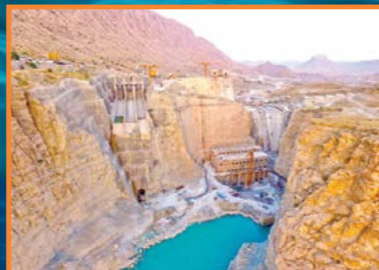
سازه‌های سرریز، نیروگاه، برجهای آبگیر و تخلیه تحتانی سد چم شیر / کچساران
